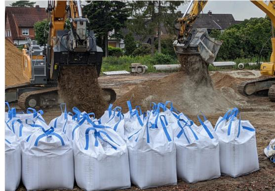
Die Einarbeitung von **soilfixX** hat homogen in die vorbereitete Bodenschicht/-miete zu erfolgen. Je nach Bodenart und der darauf abgestimmten Bindemittelmischung sollte die Verdichtungsarbeit direkt oder nach einigen Stunden Liegezeit erfolgen.
